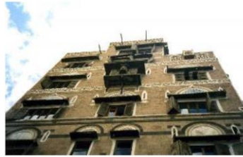
شكل (7-2) المشربية الخشبية وموقعها وبروزها على الواجهات التقليدية يعطي الواجهات حركة ديناميكية تلغي الجمود والصمت . (الباحث)
