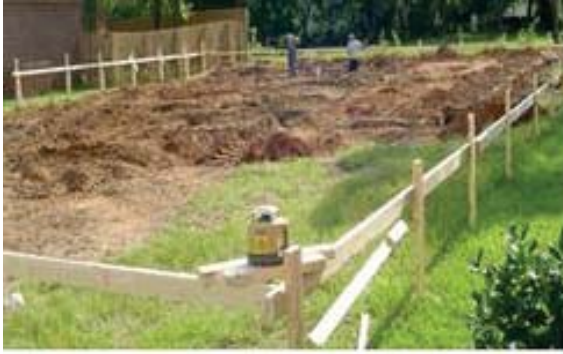
الشكل (2أ) اختيار الموقع ووضع علامات الحفر والخزيرة
