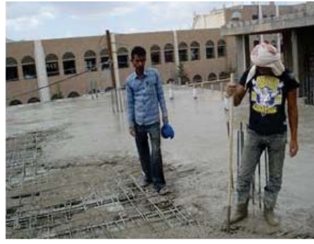
الشكل رقم (21) الصورتين توضح صببة سطح تظهر فيه السيولة الكبيره في الخرسانة والتي يعني أن نسبة الماء عالية (الباحث)
