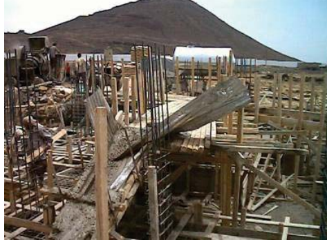
الشكل رقم (20) يبين طريقة الصب باستخدام مصب مخالف للقواعد الفنية فيتسبب بالفصل الحبيبي (الباحث)
