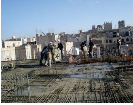
الشكل رقم (21) الصورتين توضح صببة سطح تظهر فيه السيولة الكبيره في الخرسانة والتي يعني أن نسبة الماء عالية (الباحث)
