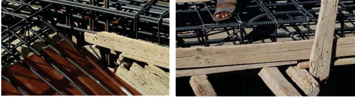
الشكل رقم (24) يبين الفصل بين الواح السطح والجنب الحاجز وقدم الاخشاب الشكل رقم (25) يبين طريقة وضع الخشب في الدرج والفراغات والفجوات (الباحث)
