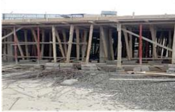
الشكل رقم (27) تجهيز الموقع واهمال ترتيب المواد وعدم الاهتمام بعوامل السلامة (الباحث)
