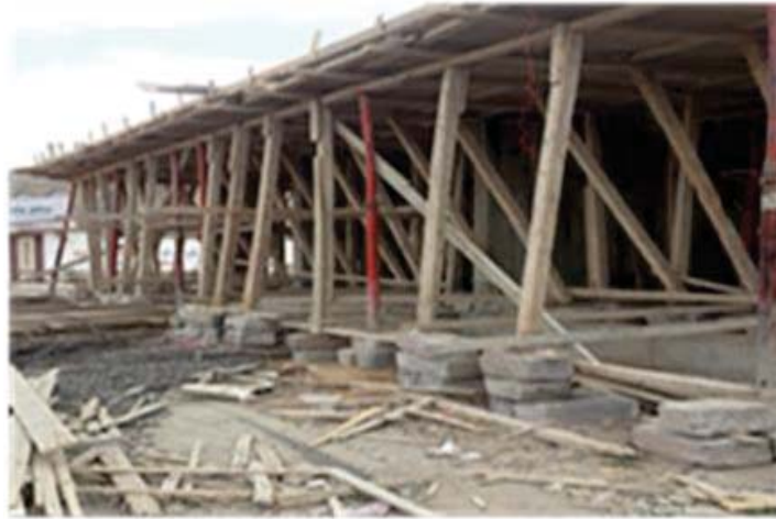
الشكل رقم (28) يبين وضع الدعامات الاغير أمن مع عدم ترتيب موقع العمل (الباحث)
