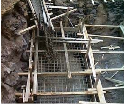
الشكل رقم (20) يبين طريقة الصب باستخدام مصب مخالف للقواعد الفنية فيتسبب بالفصل الحبيبي (الباحث)
