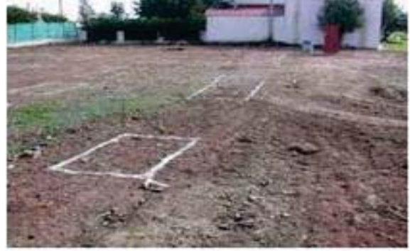
الشكل رقم (2) تحديد مواقع الحفر للقواعد علي الارض
