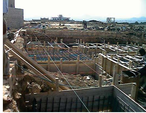
الشكل رقم (17) اربعة صور من الواقع تبين طريقة اسقاط المحاور علي القواعد بالاعتماد خيوط من الخنزيرة (الباجت)
