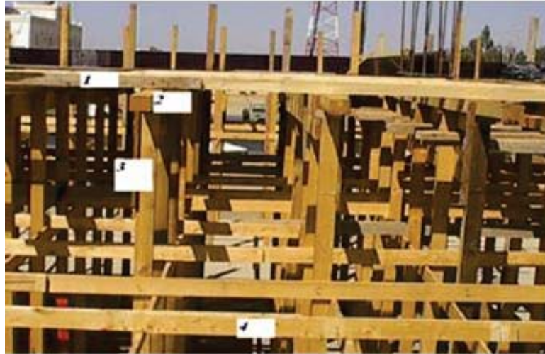
الشكل رقم (8) يبين تجهيز شدات السطح بالطريقة السورية www.Kutub.info المفاتيح = (1) التطاريج (2) التعريفات (3) القوائم (4) البرندات (تقويات واتزان)
