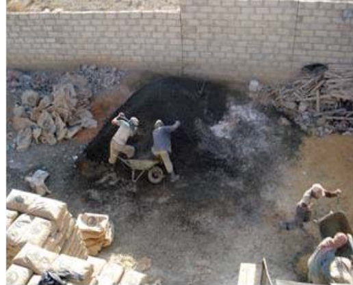
الشكل رقم (18) يبين طريقة وضع مواد الصبة دون مراعات نظافة المكان وعشوائية العمل (الباحث)
