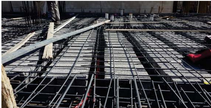
الشكل رقم (26) يبين توزيع الحديد فوق الشدات الخشبية وعدم التوزيع المتجانس (الباحث)
