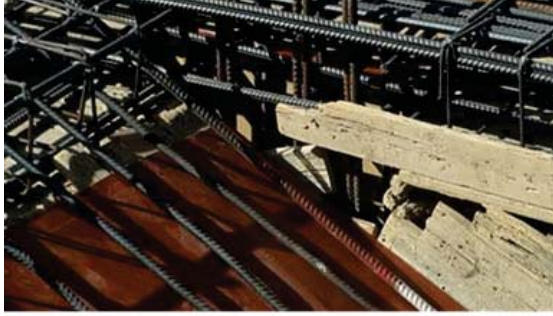
الشكل رقم (24) يبين الفصل بين الواح السطح والجنب الحاجز وقدم الاخشاب الشكل رقم (25) يبين طريقة وضع الخشب في الدرج والفراغات والفجوات (الباحث)
