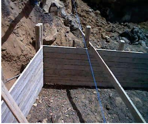
الشكل رقم (17) اربعة صور من الواقع تبين طريقة اسقاط المحاور علي القواعد بالاعتماد خيوط من الخنزيرة (الباجت)
