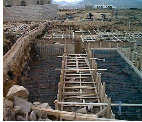
الشكل رقم (16) يبين عدم وجود التدعيم الواجب وجودة لحماية الحديد والخرسانات من الاتربة والاسواخ (الباحث)
