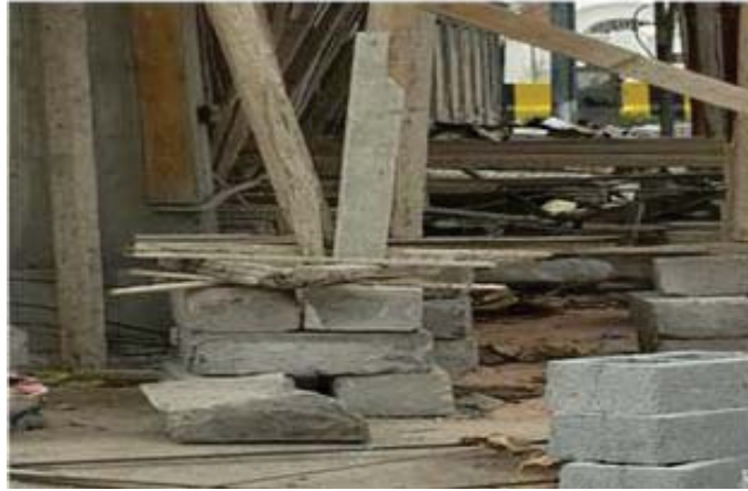
الشكل رقم (30) يبين سوء تنفيذ الدعامات بدقة ومخاطر الانزلاق (الباحث)
