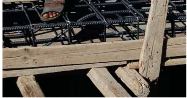
الشكل رقم (24) يبين الفصل بين الواح السطح والجنب الحاجز وقدم الاخشاب الشكل رقم (25) يبين طريقة وضع الخشب في الدرج والفراغات والفجوات (الباحث)
