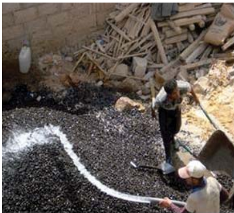
الشكل رقم (18) يبين طريقة وضع مواد الصبة دون مراعات نظافة المكان وعشوائية العمل (الباحث)
