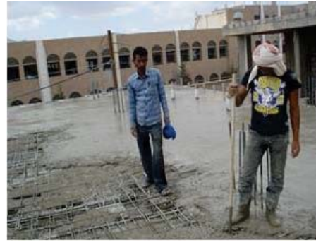
الشكل رقم (21) الصورتين توضح صبة سطح تظهر فيه السيولة الكبيره في الخرسانة والتي يعني أن نسبة الماء عالية (الباحث)
