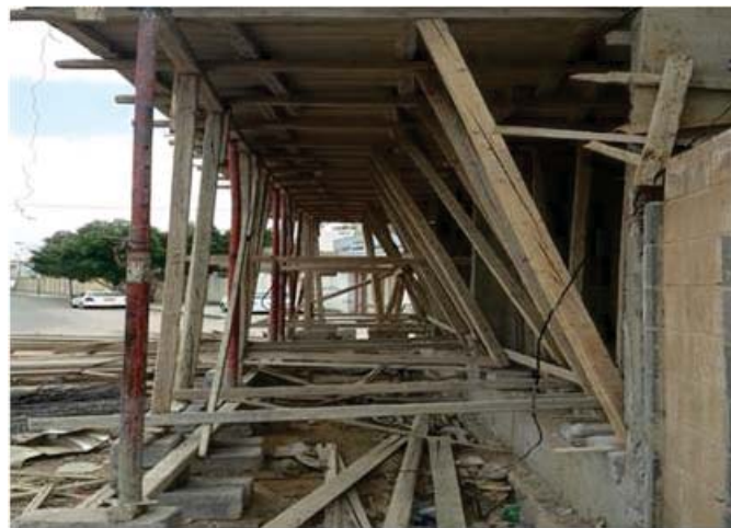
الشكل رقم (29) يبين عدم التنظيم في توزيع الدعامات وسوء الاتزان ، من زاويا مختلفة (الباحث)
