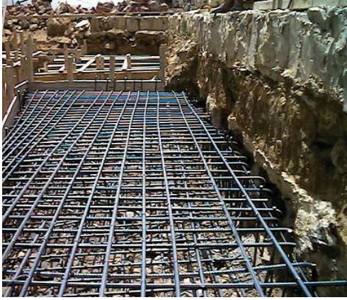
الشكل رقم (16) يبين عدم وجود التدعيم الواجب وجودة لحماية الحديد والخرسانات من الاتربة والاسواخ (الباحث)
