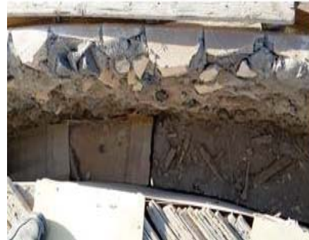
الشكل رقم (22) يبين تخشبية وعليها فواصل تسمح بتسرب لناعم في الخلطة
