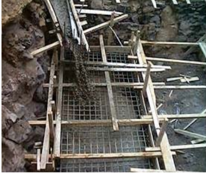
الشكل رقم (20) يبين طريقة الصب باستخدام مصب مخالف للقواعد الفنية فيتسبب بالفصل الحبيبي (الباحث)
