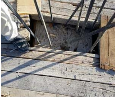
الشكل رقم (23) يبين الفتحات حول الاعمدة والتي تسمح بتسرب الخرسانة بمكيات كبير (الباحث)
