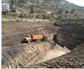
صورة لمراحل إنشاء كرف سائلة ميتم رقم (1).
