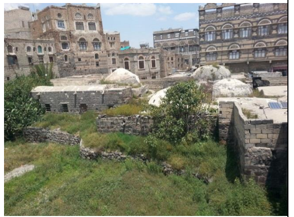
لوحة (2) الواجهة الجنوبية
