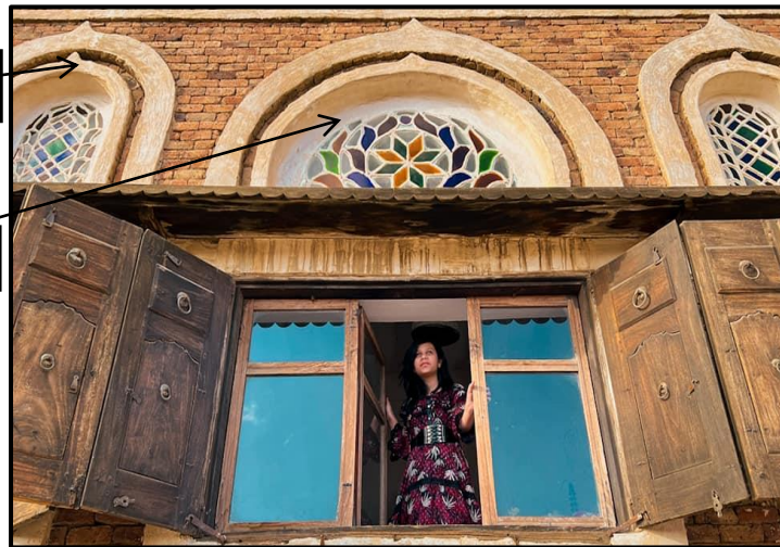
شكل (4) القمرية النصف دائرية (العقود الجصية المعشقة بالزجاج) (السنيدار، علي، 2023، 11 يناير) منشور فيس بوك، مسترجع بتاريخ 20 يناير، 2024).
