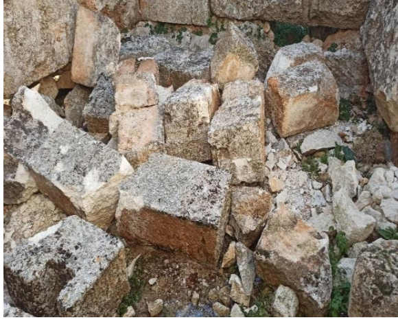
الصورة رقم (21): تكسر حجارة بعض جدران مباني موقع قرقبيزة الأثري إثر تداعيا بسبب زلزال عام 2023م، تصوير الباحث، عام 2023م.
