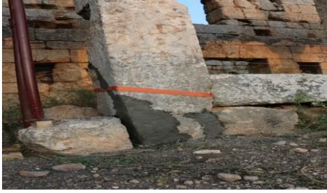
لوحة (31) أ، ب، تدعيم الدعامة من الأسفل، (نقلًا عن مركز آثار إدلب، 2023م)
