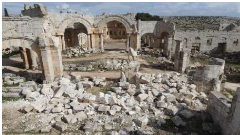
لوحة (29)، القوس المنهار بفعل الزلزال، (تصوير الباحث، 2023م).
