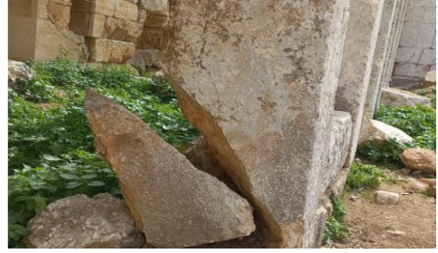
لوحة (31) أ، ب، تدعيم الدعامة من الأسفل، (نقلًا عن مركز آثار إدلب، 2023م)
