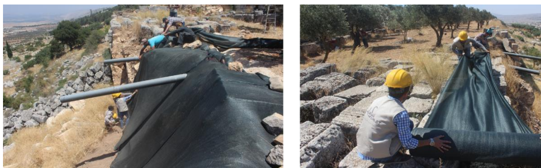
لوحة (25) أ، ب، عملية تغطية المكان المكشوف من السور بشبك الظل، (نقلًا عن مركز آثار إدلب، 2020م)
