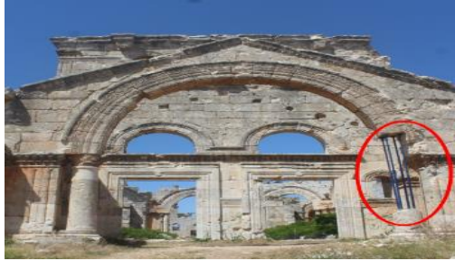
لوحة (22) أ، ب، تركيب الأعمدة المعدنية عوضًا عن العمود الحجري، (نقلًا عن مركز آثار إدلب، 2020م).
