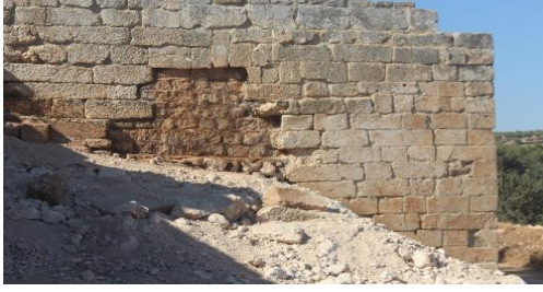
لوحة (20)، ترميم الفتحة بالسور الشرقي، (نقلًا عن مركز آثار إدلب، 2019م).
