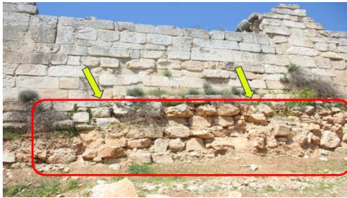
لوحه (18)، أ، الفتحة في السور. لوحه (18)، ب، تجريف أساسات السور الشرقي وتعريضها، (نقلًا عن مركز أثار إدلب، 2017م).
