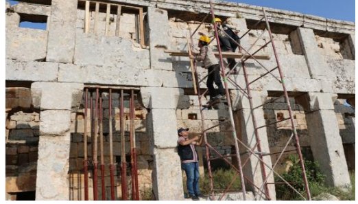
لوحة (31) أ، ب، تدعيم الدعامة من الأسفل، (نقلًا عن مركز آثار إدلب، 2023م)
