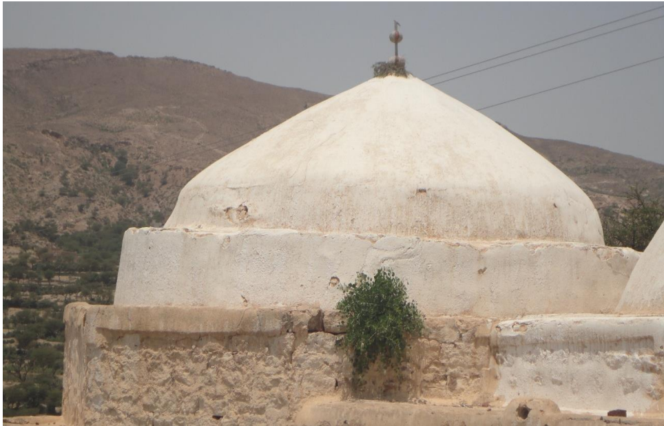
(لوحة 8) قبة التوسعة وهلالها من الخارج، والمتمن فوق مستوى السطح
