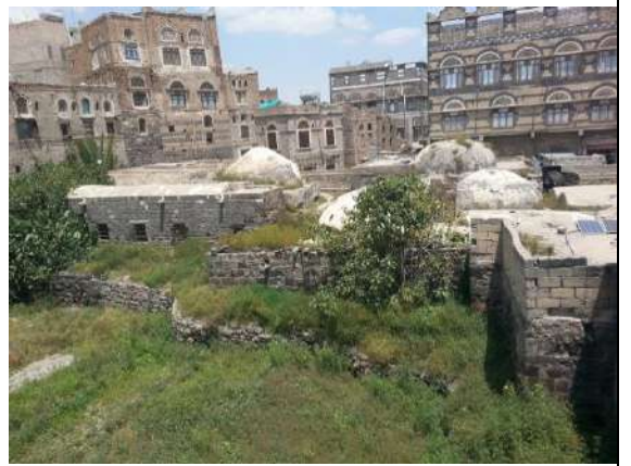
لوحة (2) الواجهة الجنوبية
