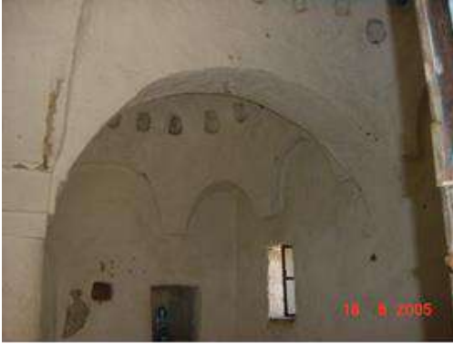
لوحة 32 الحنايا الركنية التي غيرت التخطيط وتحمّل أبدان القباب الأربع التي تغطي السقف (تصوير الباحث)
