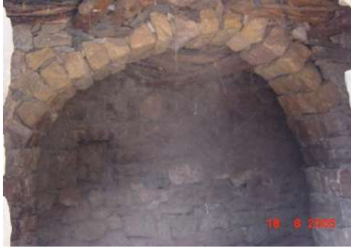
لوحة 19 تقنية العقود المستخدمة في بناء الأدوار السفلى (تصوير الباحث)
