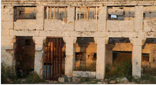
لوحة (31) أ، ب، تدعيم الدعامة من الأسفل، (نقلًا عن مركز آثار إدلب، 2023م)
