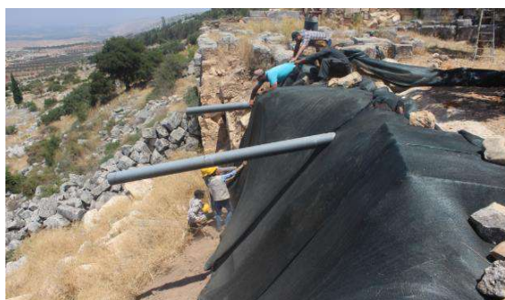
لوحة (25) أ، ب، عملية تغطية المكان المكشوف من السور بشبك الظل، (نقلًا عن مركز آثار إدلب، 2020م)
