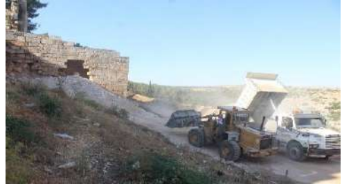
لوحة (19)، عملية طمر أساسات السور، (نقلًا عن مركز آثار إدلب، 2019م).
