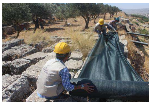
لوحة (25) أ، ب، عملية تغطية المكان المكشوف من السور بشبك الظل، (نقلًا عن مركز آثار إدلب، 2020م)
